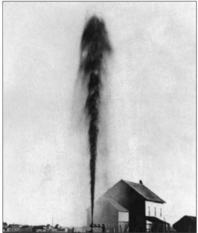
▲ Figura 17.12 Pozo artesiano que fluye «en forma de surtidor» en Dakota del Sur a principios del siglo xx. En la actualidad se explota el mismo acuífero confinado a través de millares de pozos adicionales; por tanto, la presión ha descendido hasta el punto de que muchos pozos han dejado de fluir por completo y deben bombearse. (Foto de N. H. Darton, U. S. Geological Survey.)
